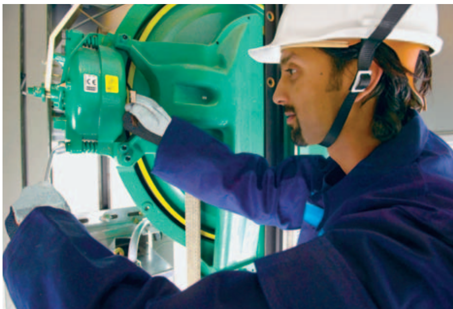
KONE EcoDisc® -nostokoneisto vähentää energiankulutusta jopa 70 prosenttia.
