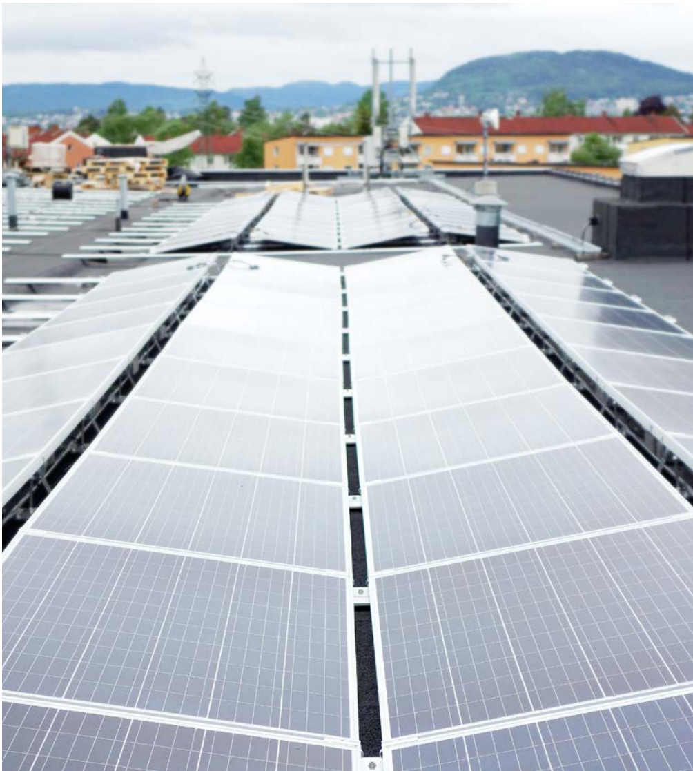
180 aurinkopaneelia asennettiin KONEen Oslon-pääkonttorin passiivienergiataloon toukokuussa 2016. Ne peittävät kolmasosan katon pinta-alasta.
